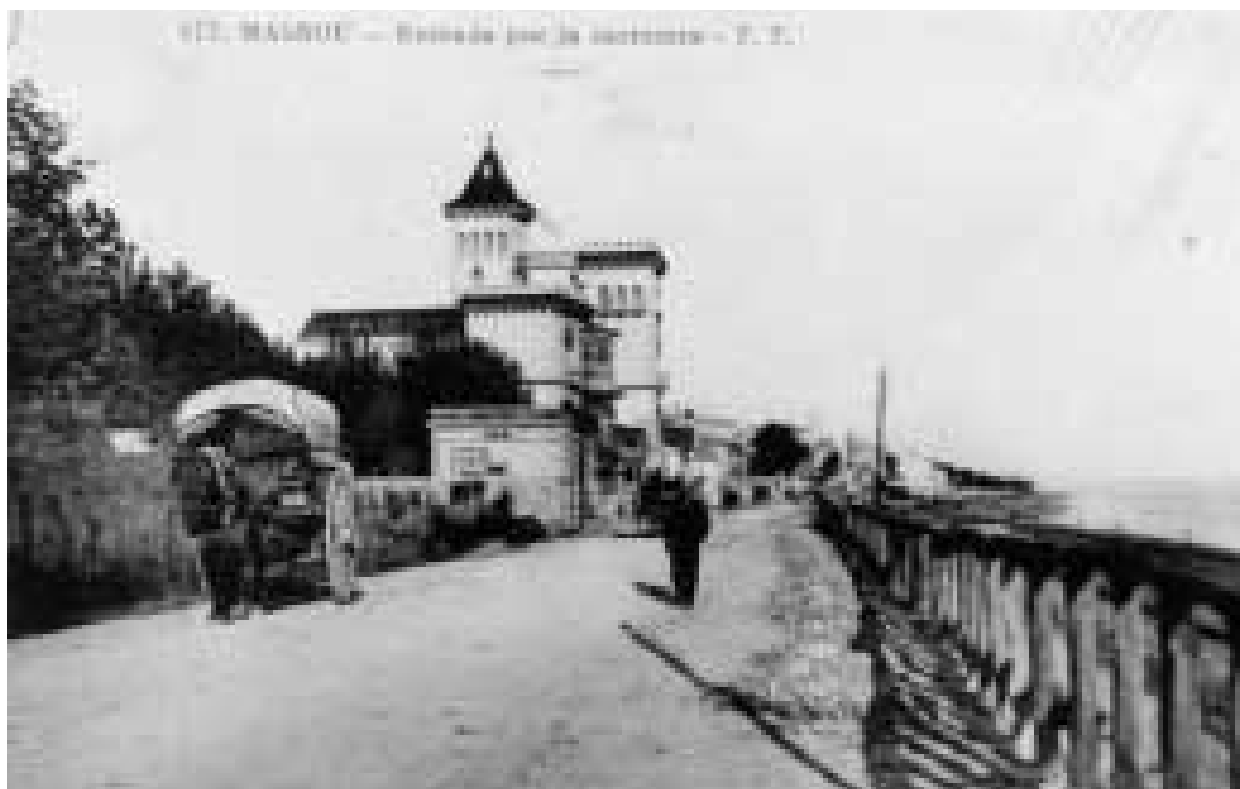
Una tartana circula per l'entrada al Masnou pel Camí Ral. Destaca l'imponent edifici de Ca l'Aymà (El Castellet). Inicis del segle XX. Autor: desconegut. Núm. de registre: 1111, AMM.
